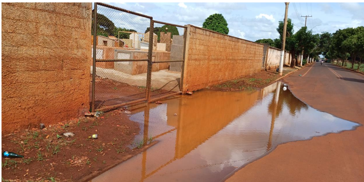
Figura 01 - Vista do local ilustrando desnível no leito carroçavel, defronte do portão de acesso a parte nova do Cemitério.
