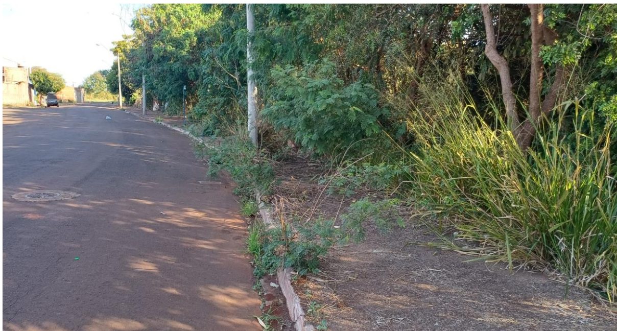
Figura 01 -. Vista da calçada pública necessitando da retirada da vegetação, para o uso seguro dos pedestres quando caminham pelo local.
