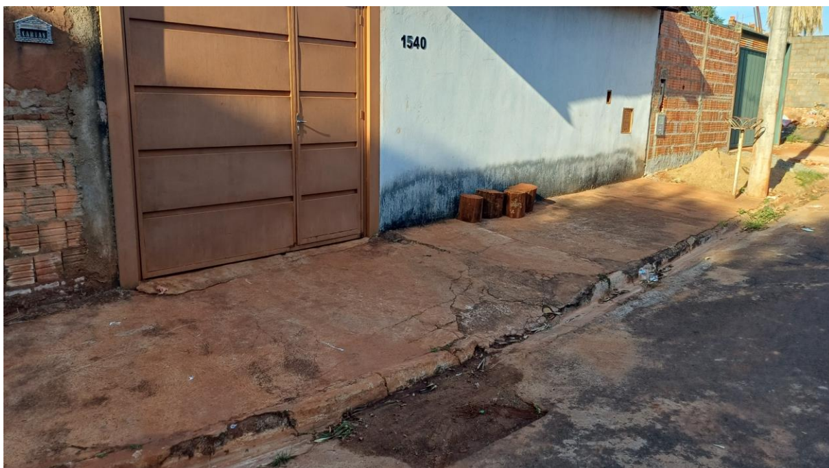
Figura 02 -. Vista do local ilustrando a necessidade de limpeza do local conhecido popularmente por “Boca de Lobo”, no sistema de escoamento de águas, defronte o imóvel de número 1540.
