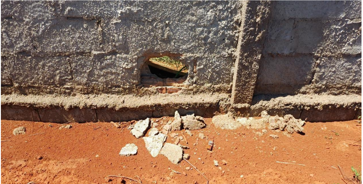
Figura 03 -. Vista do local ilustrando parte inferior do muro que circunda o imóvel onde esta instalado um poço artesiano profundo da Autarquia DEAGUA, que abastece água a nossa população.
