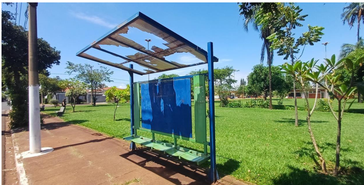
Figura 01 -. Vista do local ilustrando ponto de embarque de ônibus, cuja estrutura necessita de restauração em especial em sua cobertura para gerar conforto e segurança aos munícipes.
