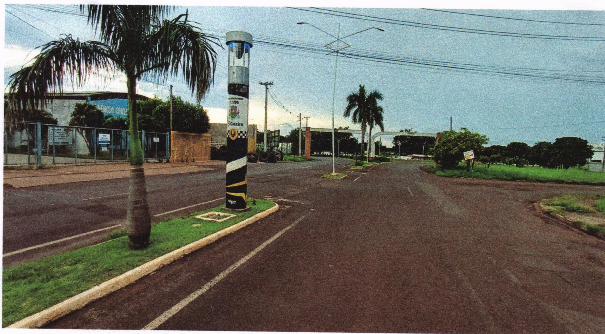
Figura 02 -. Vista do local ilustrando via de saída de nossa cidade, com transito de veículos que passam pelo Totem sem controle de velocidade, o que dificulta identificação nitida de placas veiculares.
