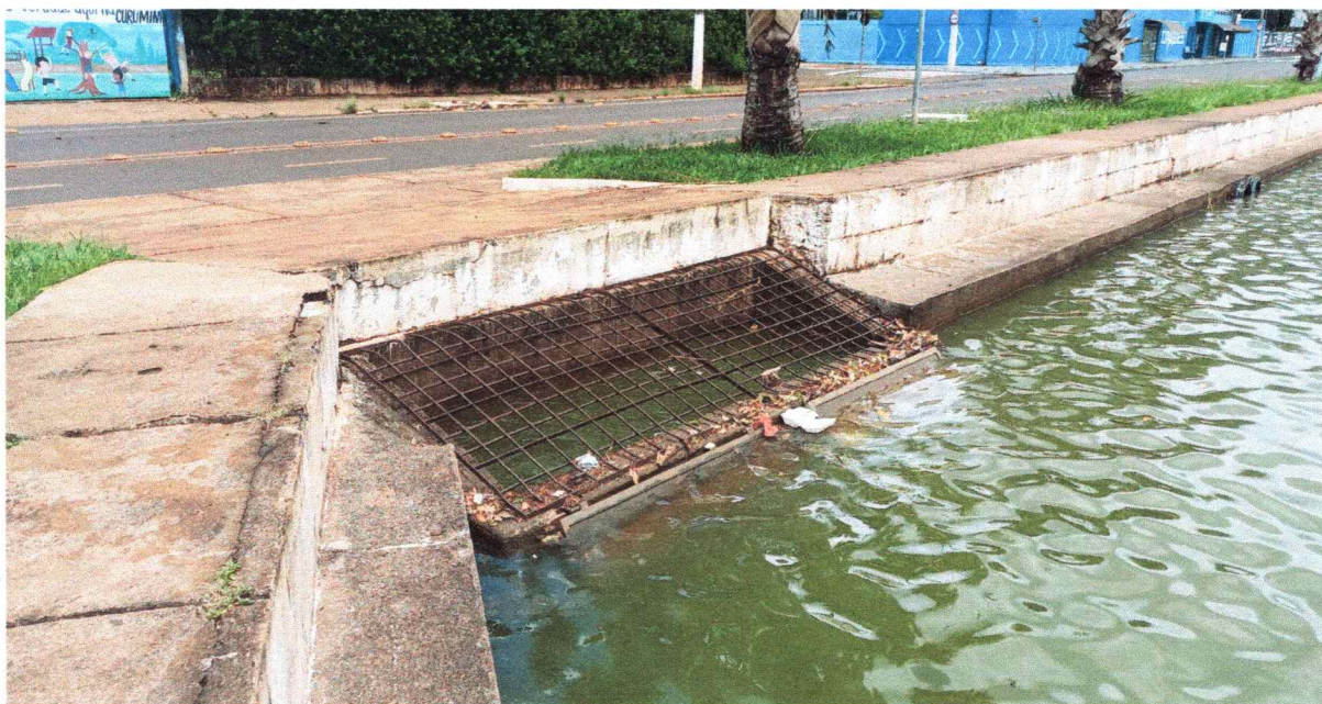
Figura 01 - Vista do local ilustrando uma comporta no Lago Maracá, que permite a vazão da água, quando apresenta seu nível elevado.
