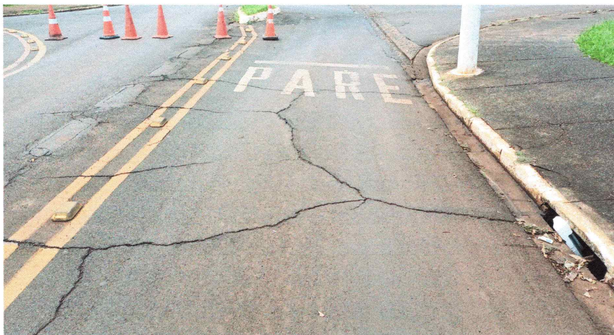
Figura 02 - Vista do local ilustrando a via pública no leito carroçavel com fisuras/trincas, nas proximidades da comporta de vazão do lago onde existe um bueiro.
