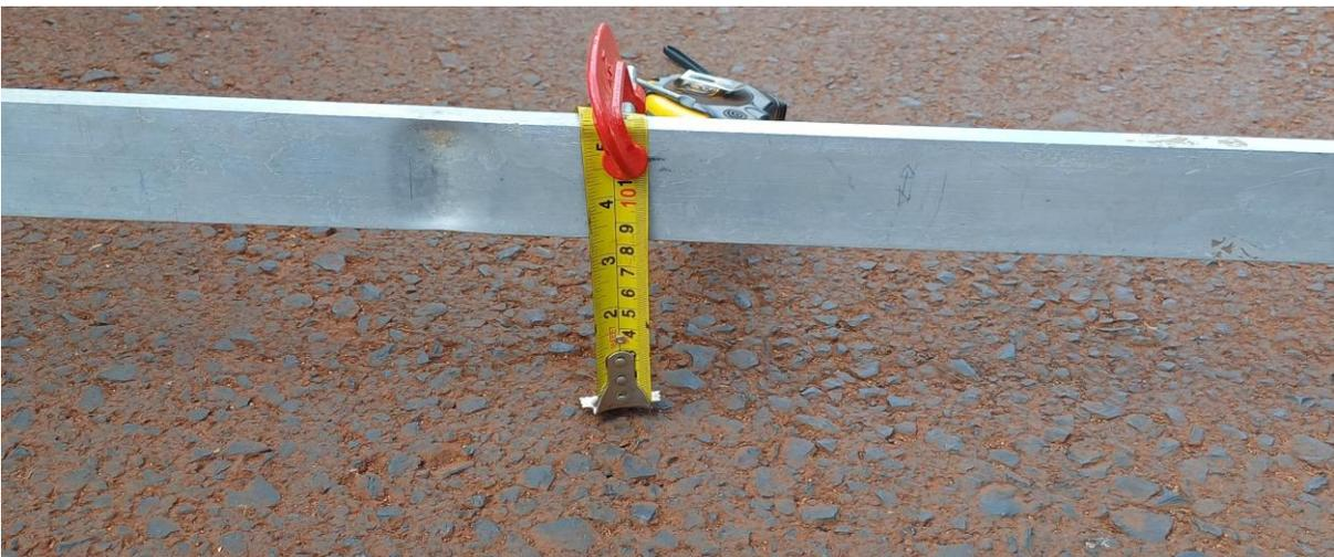
**Figura 04** - Vista do local ilustrando medição referente ao desnível na via pública, contribuindo para o acumulo de águas pluviais.
