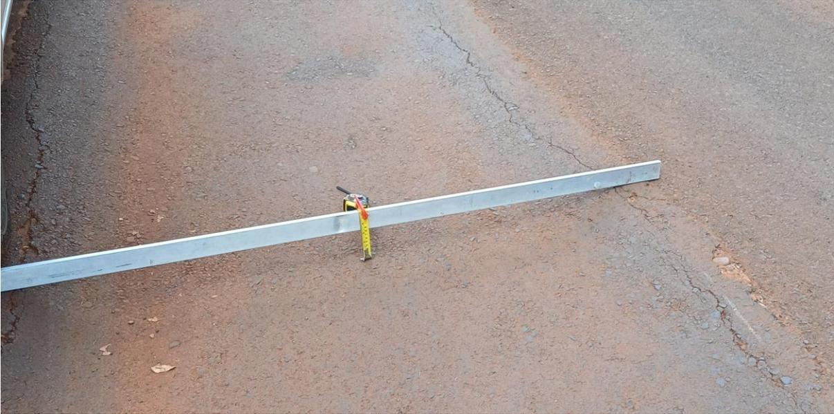
**Figura 03** - Vista do local ilustrando uma régua em alumínio com uma trena, para desmonstrar a profundidade existente no local, o que na ocasião das chuvas gera desconforto aos moradores.
