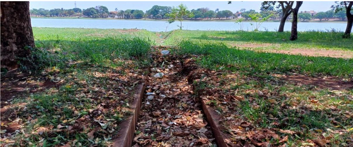
**Figura 04** - Vista do local ilustrando uma canaleta construída em alvenaria para escoar águas pluviais necessitando de limpeza em seu interior a qual localiza-se próximo a pista de Skate.
